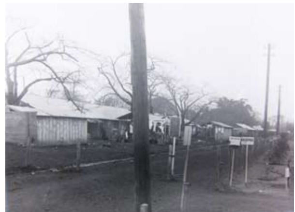
図3: 関東大震災の被災者のための急設救護所 (大正12年秋～冬頃)
